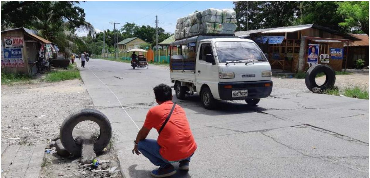
**FIGURE 21: CORNERBREAK, LONGITUDINAL AND TRANSVERSE CRACKS AT PACKAGE 1 (AWANG-NORTH UPI ROAD SECTION)**
